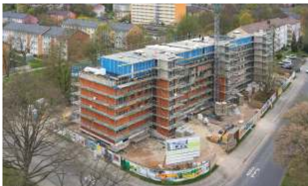
2017: Eingerüstet auf fünf Etagen
